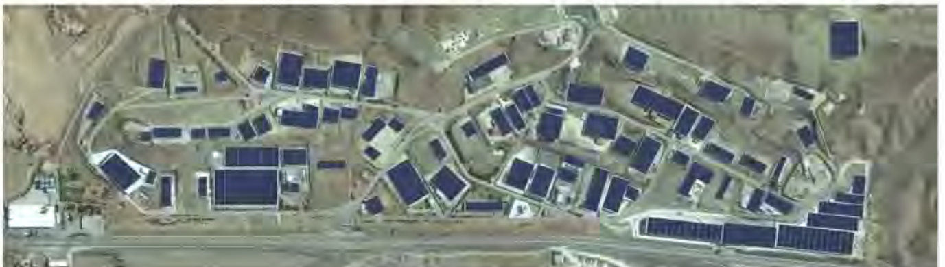
Şekil 17: KOSB Firmalar GES Fotovoltaik Panel Kurulumu
